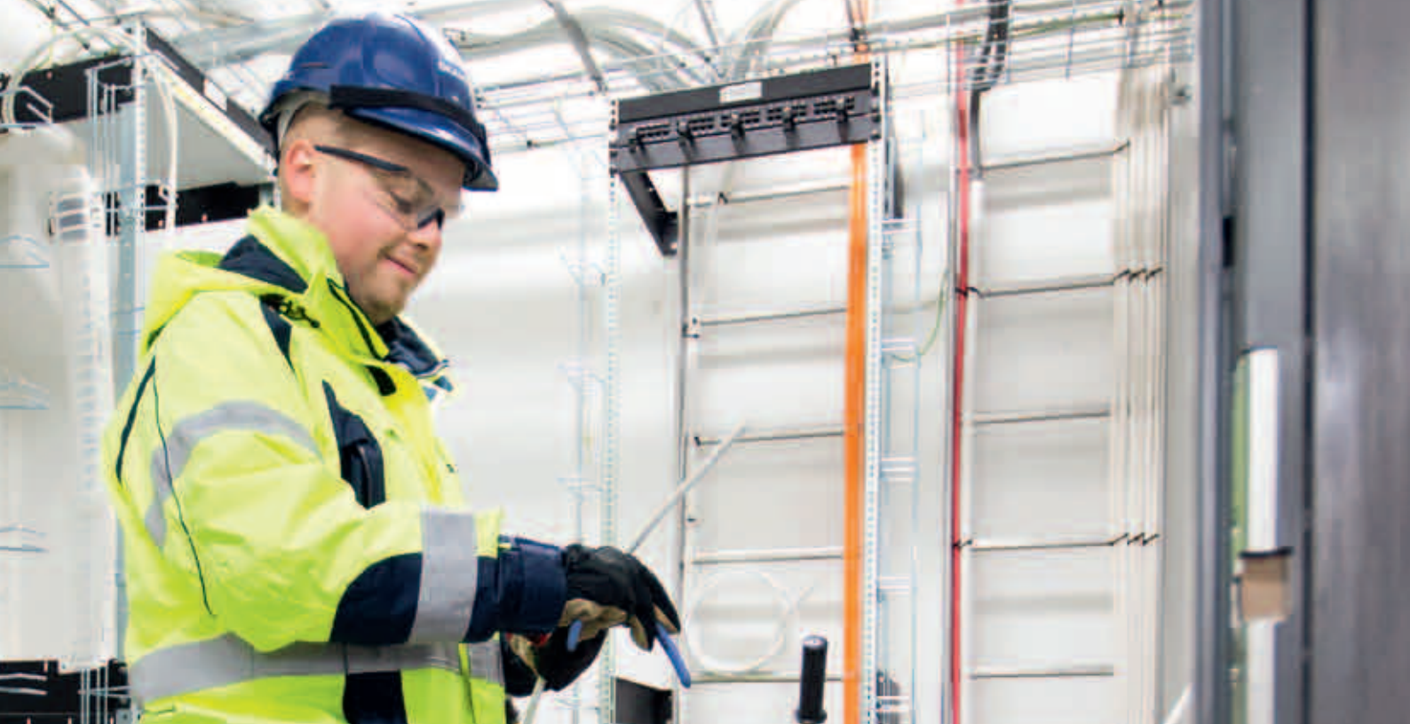
Andreas Dahlström installerar Nexans Easy-kabel på Nya Karolinska Solna. Nya Easy-kabeln är halogenfri och ger inte ifrån sig giftiga gaser vid brand, vilket är viktigt på ett sjukhus.
