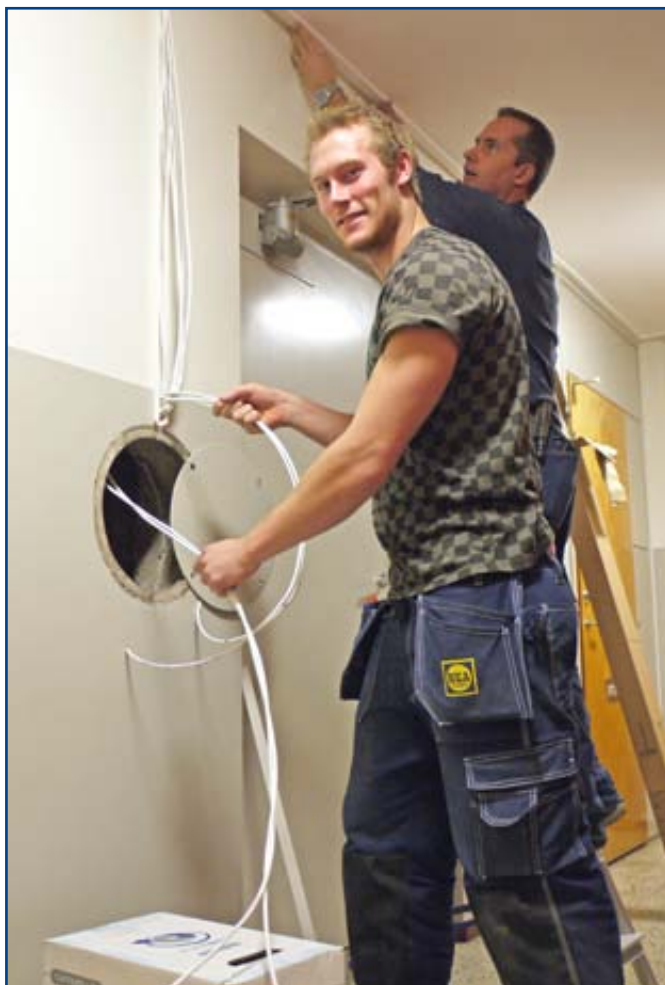
Ovan bild: NEA:s montör Roger Svensson sätter upp uttag i hallen på en lägenhet Fregattvägen Näsby Park.
