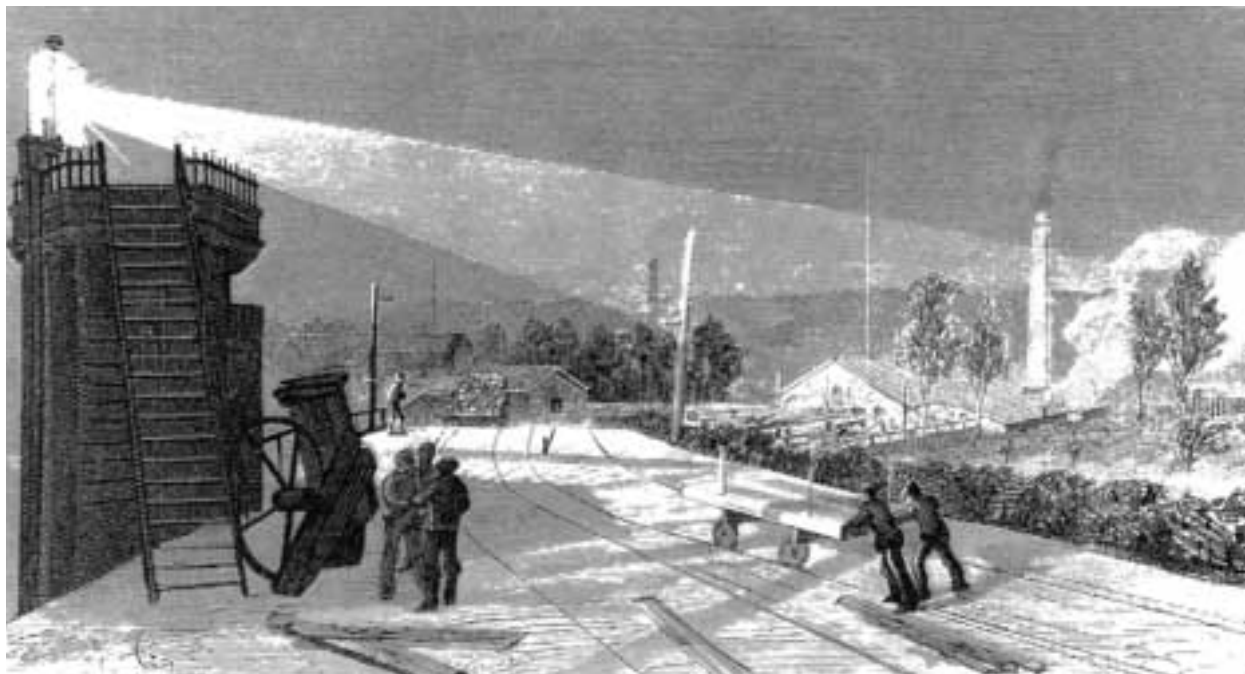
Bågljusbelysning vid Näs sågverk i Hälsingland. Bilden ur Ny Illustrerad Tidning 1878. Sågverkschefen J S Nisser framhöll bågljusets fördelar framför fotogen och gasbelysning. Det starka bågljuset lyste upp så bra att man kunde arbeta med virkessortering även på natten.
