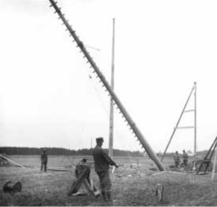
Resning av betongstolpe 1930 på den 13 km långa ledningen mellan Lanforsen och Untran. Denna linje har kvar ursprungsspänningen 100 kV än i dag.
