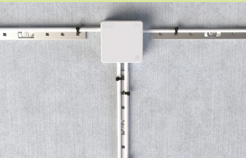
Montage av kabel med najtråd, strips eller dylikt.
