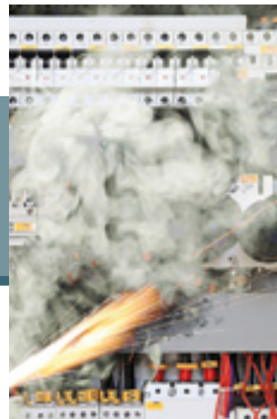
I artikeln används byte av kabelskåp som exempel.
