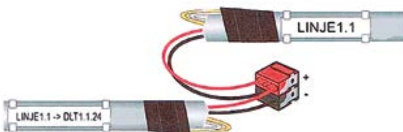
BILD 5. KNX-kabelns avmantling, förgrening/skarvning och märkning
