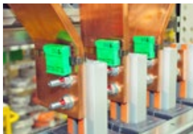
Exempel på temperatursensorer Easergy TH110 från Schneider Electric
