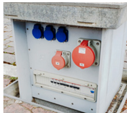
Enhet med uttag på stadens torg – utan väderskydd för dvärgbrytare och jordfelsbrytare.
