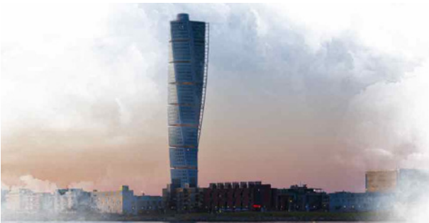
Färganpassat åskledarsystem, potentialutjämnings-system, överspänningsskydd samt UPS.
