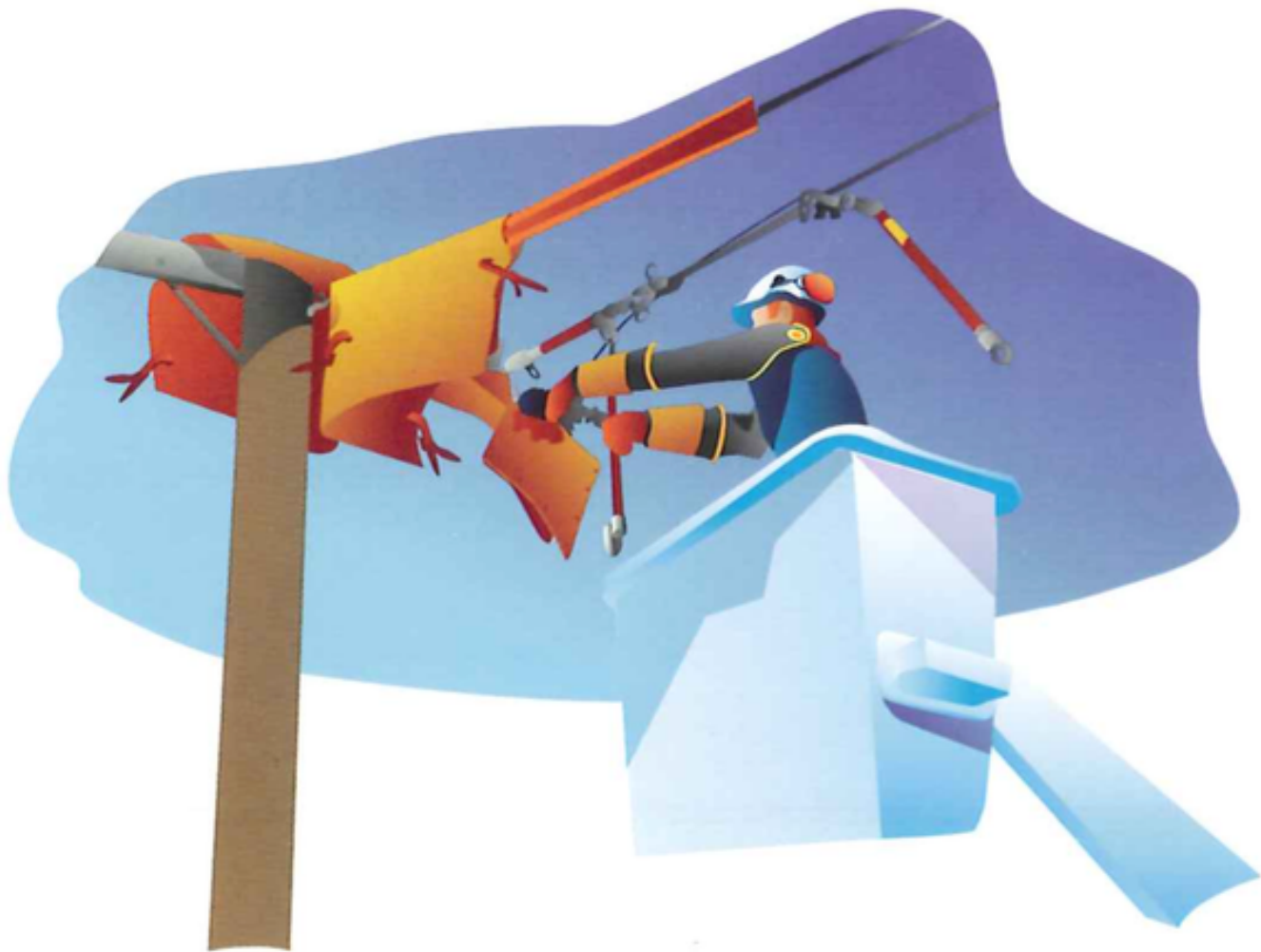
Bild 32. AMS arbete med isolerhandskmetoden.
