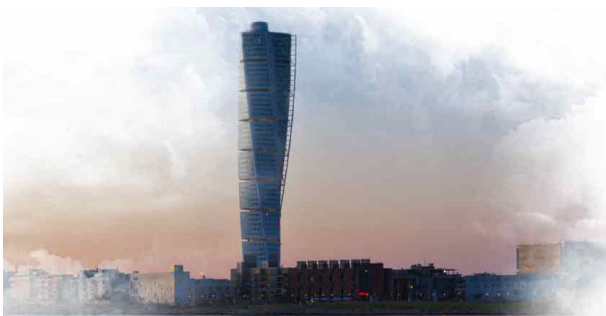
Färganpassat åskledarsystem, potentialutjämnings-system, överspänningsskydd samt UPS.
