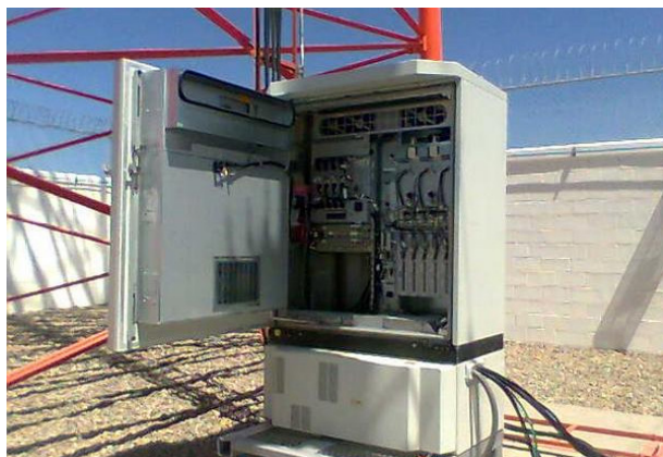
Överspänningsskydd för radiobasstation.
