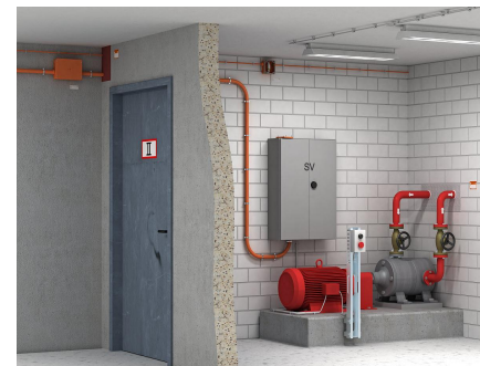
Sprinkleranläggning
