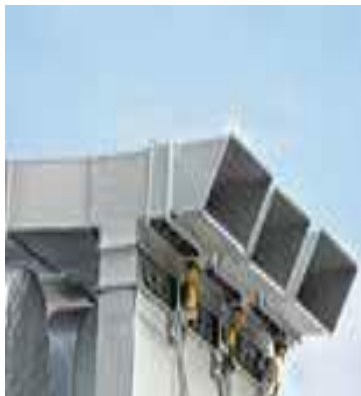
Rökutsugsfläktar/ rökluckor
