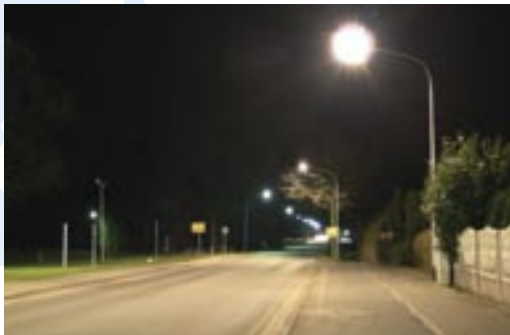
Lohne i Tyskland – i färggrunden Koffer 2 med 1 x MASTER CosmoWhite 60W, i bakgrunden armatur med 2 x HPL 125W
